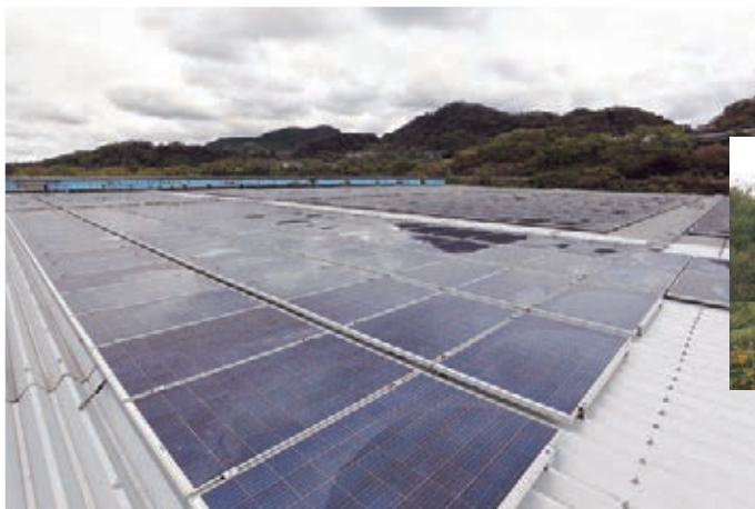
フリーバーン牛舎の屋根には太陽光発電機を設置。牛舎内の暑熱対策にも役立っている。
