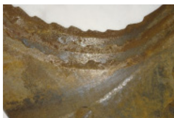
研磨前に予め錆と汚れを取り除きます
